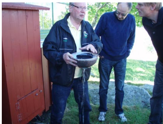
LA visar exempel på ett grovfilter till köksavloppet
