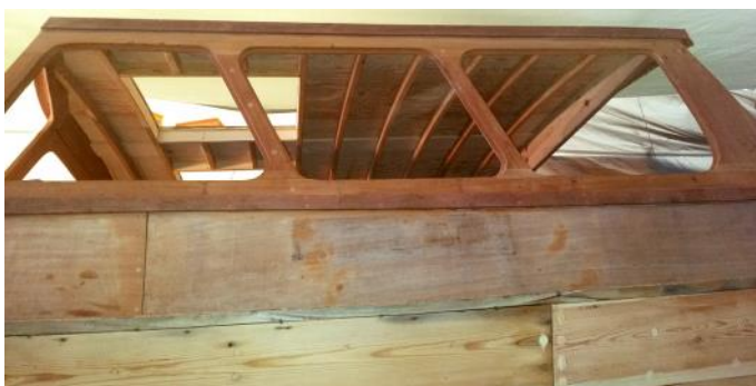
Rutorna på styrhytten skall snart monteras.
