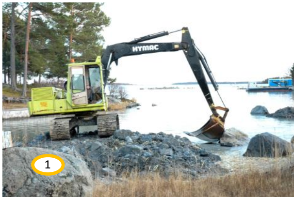
Bild 1: Sista delen i Svartsunds-rännans renovering var det södra inloppet. Det var hård botten och mycket stenar, och blev betydligt dyrare än planerat.
