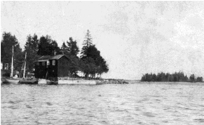
Fyrvaktarbostaden med fyr och kajanläggning på Skuggskär nära Sandarne. Käringsnolaskär till höger. I dag syns lämningar av husgrund och stenkistor.
