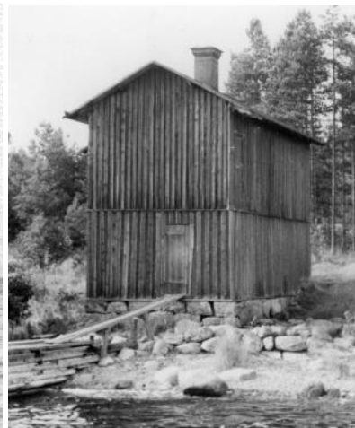
Längst upp i sydöstra hörnet under taket syns luckan till fyrrummet.
