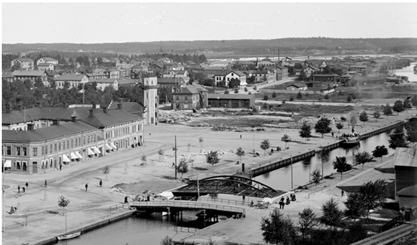
Det nya seklet kommer med en stilig järnbro direkt från den mekaniska verkstaden (i bildens överkant). Den nya bron har lagts på plats, men än finns inga räcken och det kommer att ta ett par månader innan 'överlämningen' sker. Foto arkiv: Sahlin. Beskuret. Fotot daterat 9/9 1900.
