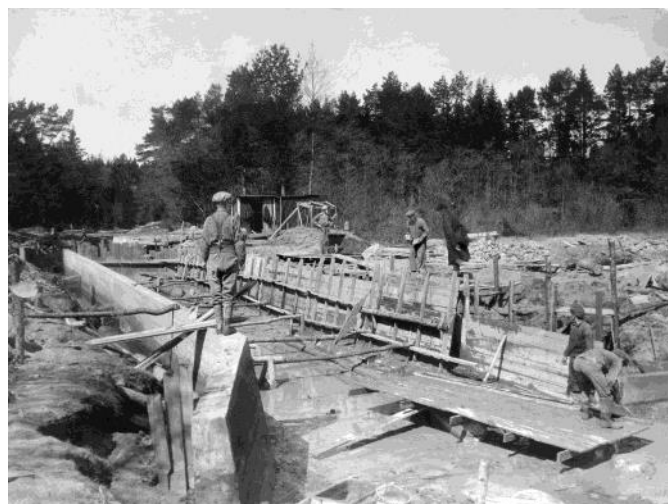
Gjutningsarbete vid renoveringen 1928.
