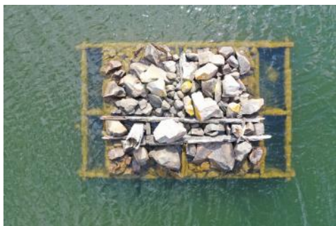
Två bilder från Söderhamnsfjärden. Drönarbilder som visar dykdalber och stenkistor. FOTO: Clas Ternström Sweco.
