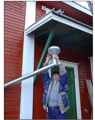
Plåtslagare Tore Wallström monterar ett tidsenligt stuprör.
