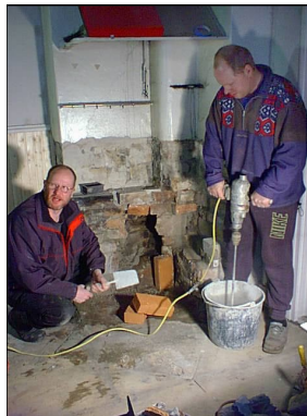
Håkan Nilsson och Mikael Hjelm skall sätta in vedspis i köket i hus 2. Tidigt arbete som gjordes på Gäddan.
