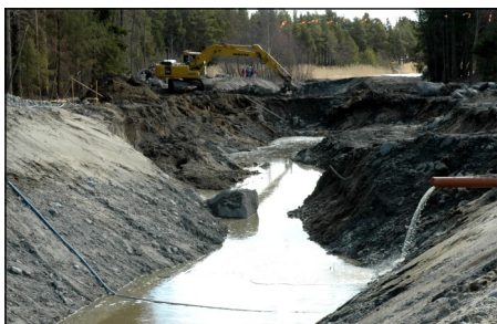
Efter att ha stängt av vattnet i båda ändar, kunde grävningen pågå.
