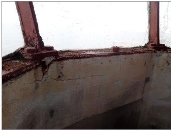
Hällgrund 2019. Upprustningen av fyren omfattar bland annat rostangrepp både inne i fyren och räcken på utsidan. Ovanför dörren till fyren sitter en platta med det årtal då fyren togs i drift.
