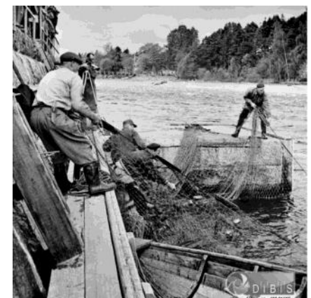
Annat exempel på notdragning, på södra sidan av Ljusnan. FOTO: SWL 1696 /Dibis/
