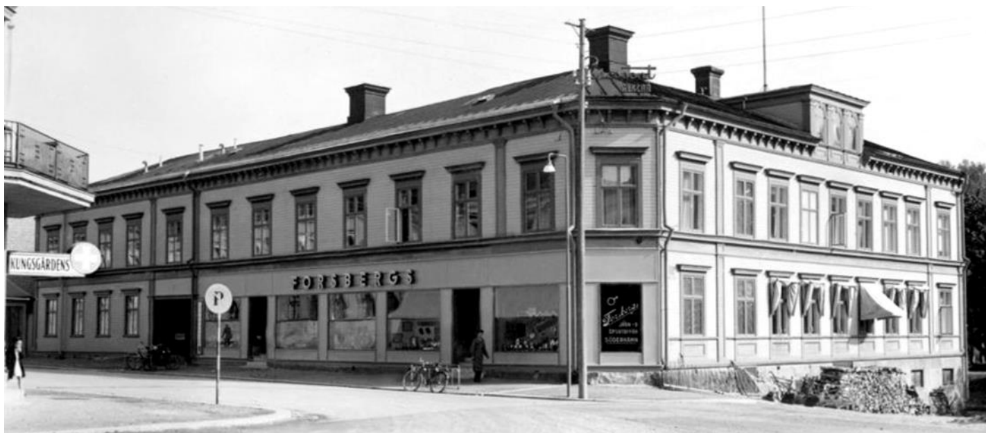
På övervåningen låg familjens bostad. På gatuplanet t.v. ingång till sportavdelning t.h. ingång till järnaffär, fönstren på gaveln med markiser var kontorsdelen.
