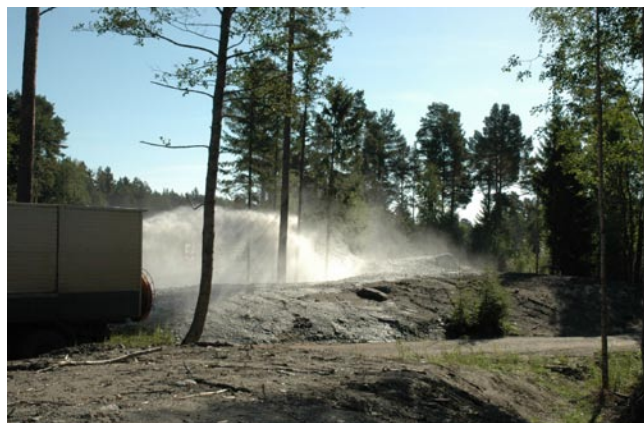
Sprutsådd vecka 35 av fastlandssidan. Arbetet utförs av Danielsson gräsetableringar ifrån Piteå. Skatlandet såddes strax före midsommar, men tack vare den senaste tidens regn har gräset tagit över ogräset.
