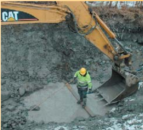
Micke Johansson kontrollerar att man nått rätt bottennivå i södra delen av rännan. Nu återstår det besvärliga mittenpartiet .
